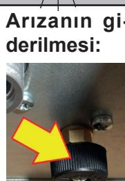
Kombi dolum musluğu aracılığıyla basıncı artırarak doğru değere getirin (ideal çalışma için basınç değeri 0,8 ile 1 bar arasında olmalıdır). Minimum basınç değerine (0,6 bar) ulaşıldığından kombi tekrar çalışmaya başlar.
