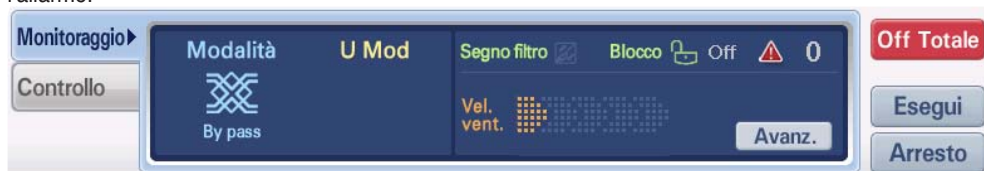
<Scheda monitoraggio ventilatore>
