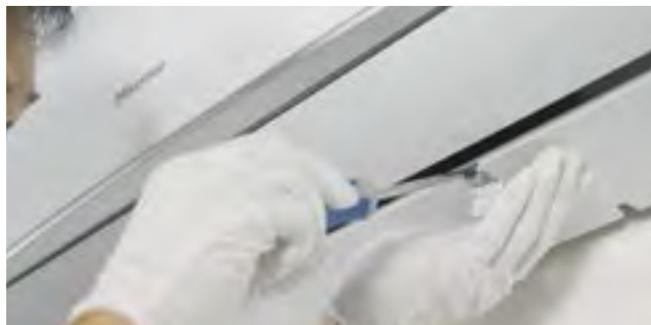
2. Il pannello posto nella parte inferiore dell'unità interna si rimuove facilmente per garantire un comodo accesso alle tubazioni.
