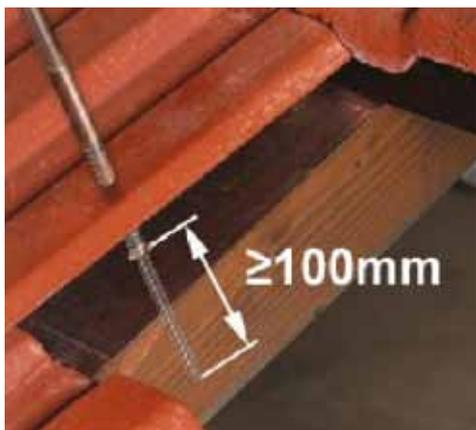
Il sistema è costituito da viti che vengono avvitate nei travi del tetto. La parte libera della vite è filettata e attraversa gli elementi di copertura (tegole) alla quale sono fissate le barre di sostegno dei collettori.
