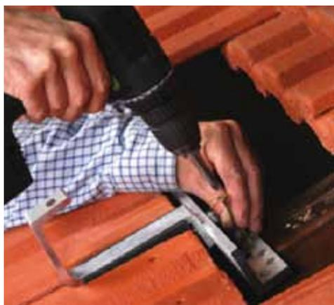
Il sistema è costituito da staffe in alluminio che si fissano per mezzo di tasselli ad espansione o viti da legno alla struttura del tetto. Le staffe, cui sono fissate le barre di sostegno dei collettori, non richiedono la foratura degli elementi di copertura.
