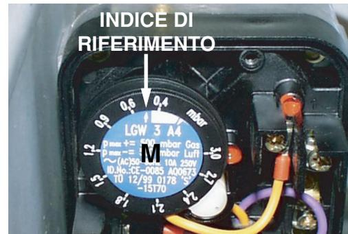
Per verificare che il valore di taratura impostato nella ghiera corrisponda al valore di pressione reale di commutazione dei contatti, procedere come segue: Avviare la caldaia, aprire lo sportellino dell'apparecchiatura e verificare il valore letto dal manometro nel momento in cui il contatto del pressostato chiude (compare un triangolo a lato dell'indicazione **DW**).
