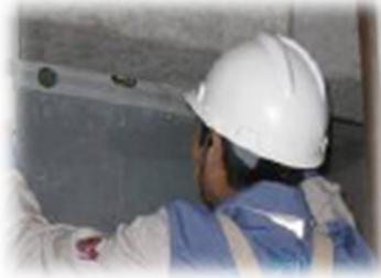
Regolare la posizione per garantire che gli spazi tra il corpo e i quattro lati del soffitto siano uniformi. La parte inferiore del corpo deve entrare nel soffitto per 10~12 mm. In generale, L è metà della lunghezza della vite del gancio di installazione.
